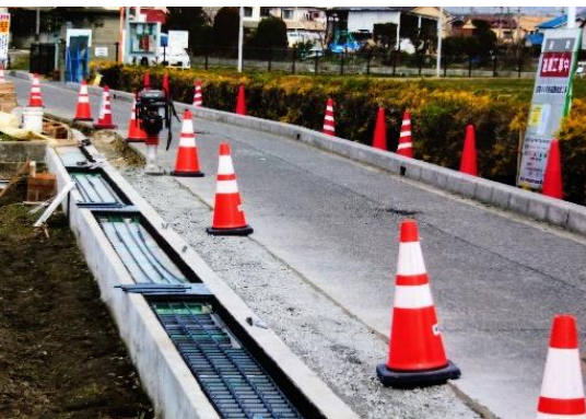
垣内公園西側道路の 拡張工事の様子
