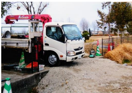
垣内公園東入り口 工事トラック通行の様子
