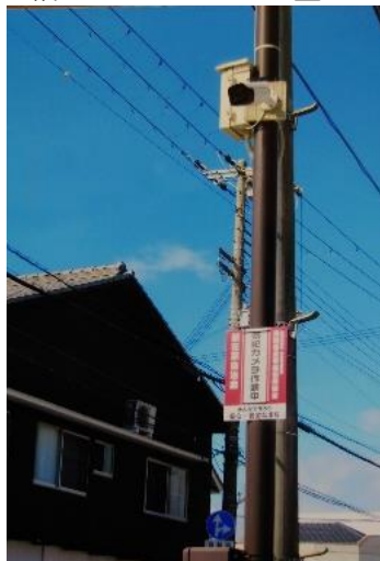
設置された 防犯カメラ
